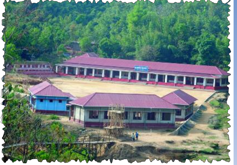
ভ্যালি ইকরান চত্বরে প্রধান স্কুলভবনের উত্তরে শিশুকাননের ৩টি স্থাপনা- একাডেমিক ভবন, স্কুল ভবন- ২ এবং সংস্কৃতি ভবন
